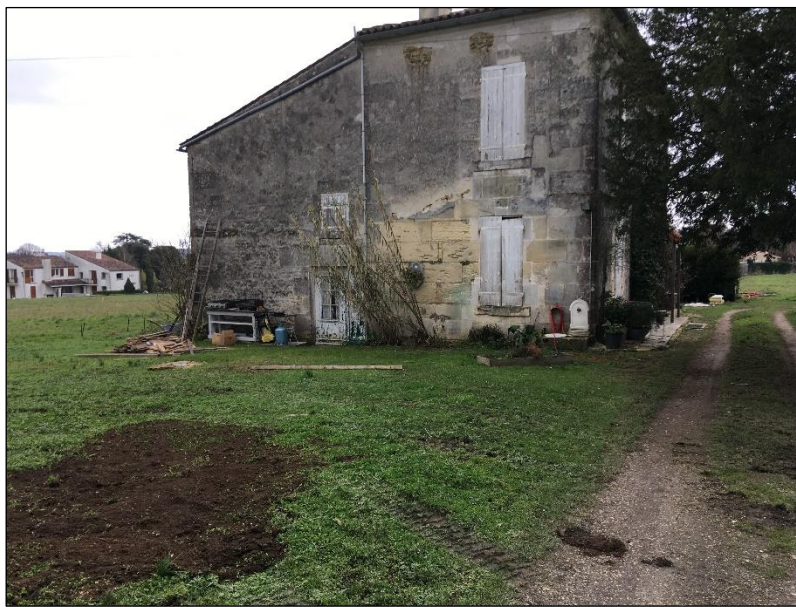
Figure 3 : Vue NO-SE du site (source DIAG+, janvier 2021)
