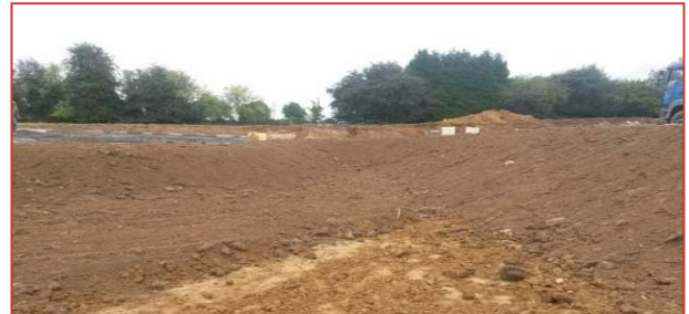
Recapage de la terre végétale
