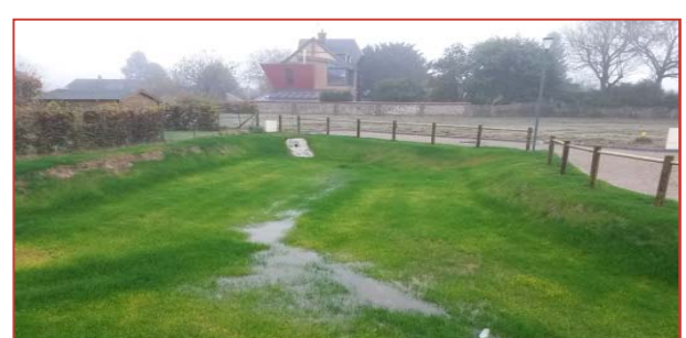
Première mise en eau de l'ouvrage
