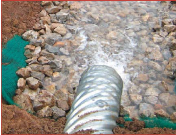
↑ Dispositifs temporaires de protection des points de rejet
