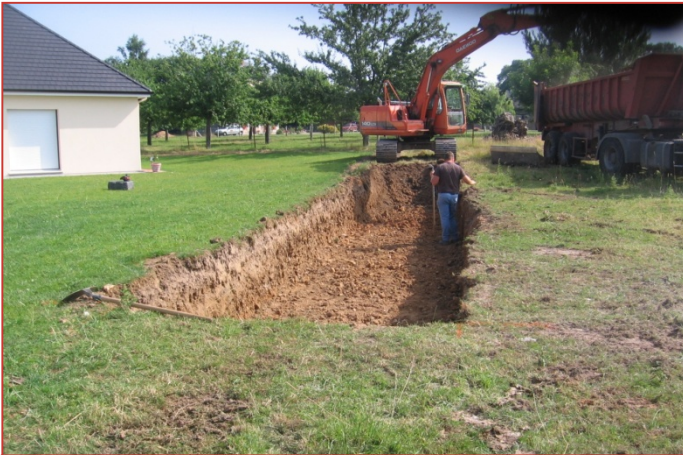
Terrassement du massif drainant
