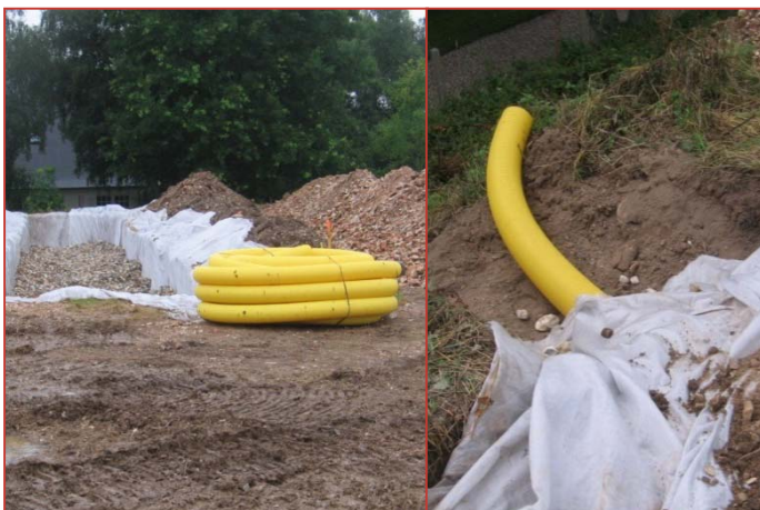
Installation de la canalisation de drainage
