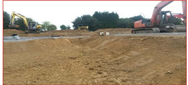
Réalisation des terrassements
