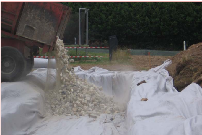
Mise en place de la grave
