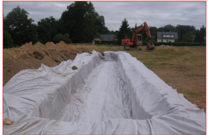
Mise en place du géotextille
