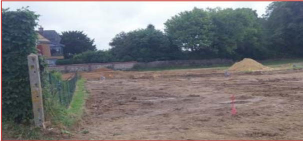
Décapage de la terre végétale
