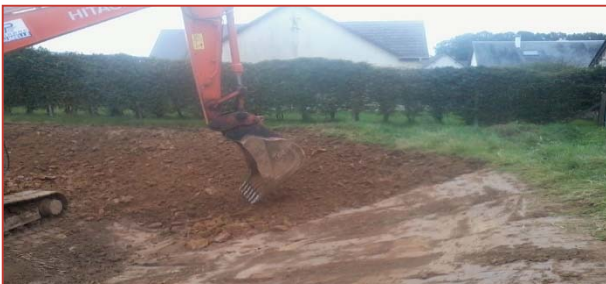
Décompactage et griffage
