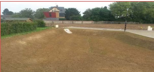
Finition des terrassements
