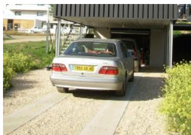
Chemin de roues en béton et grave
