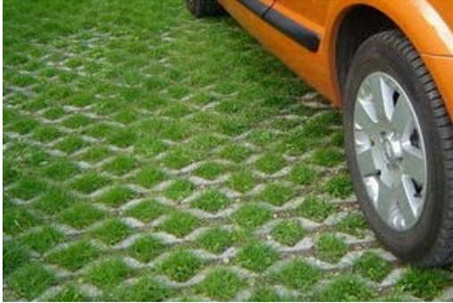
stationnement sur dalle alvéolée béton
