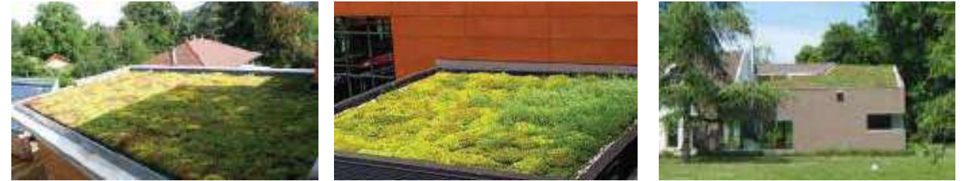
Exemples de référence de toitures végétalisées
