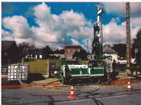
Foreuse utilisée (photo prise sur un autre site)
