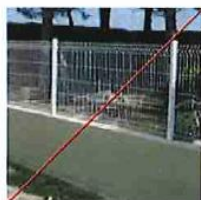
Muret maçonné réhaussé grille souple
