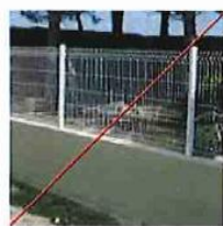
Muret maçonné réhaussé grille souple
